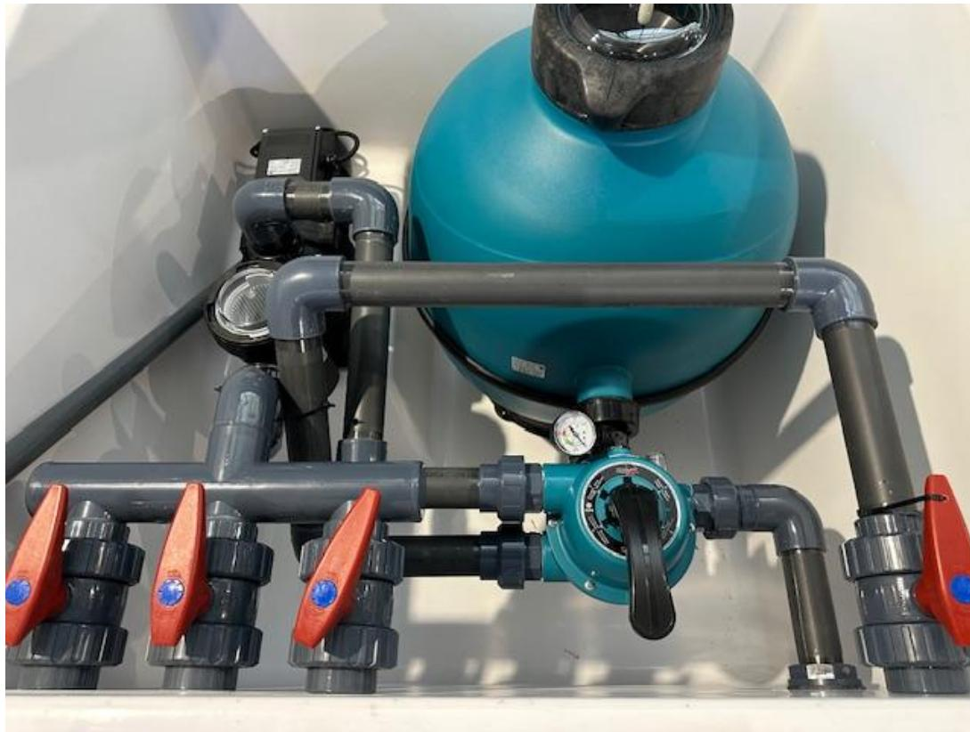
CASETA ENTERRADA CON FILTRO DE 520, BOMBA DE 1 CV, CLORADOR SALINO
