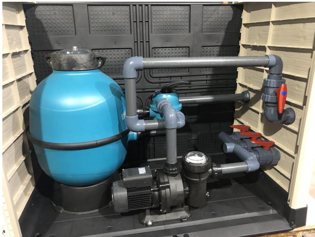
**CASETA ELEVADA CON FILTRO DE 520, BOMBA DE 1 CV, CLORADOR SALINO
